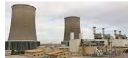
نیروگاه سیکل ترکیبی یزد
